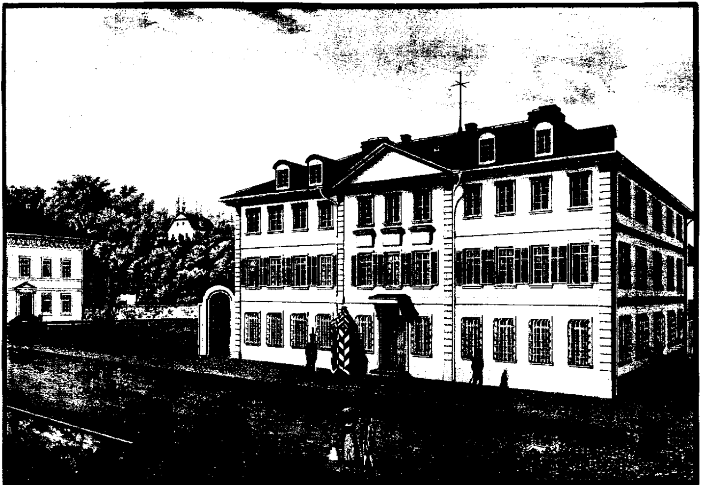
Die 1793 entworfene Kaserne des Artilleriekorps. Ausschnitt aus einem im Darmstädter Schloßmuseum befindlichen Aquarell von E. A. Schnittpahn: "Artillerie-Caserne in ihrem ersten Bestehen" (Tafel 39 aus ILLGEN, Darmstädter Bauten).
