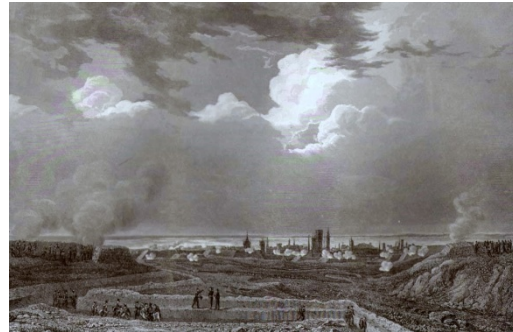
Abbildung 8: Belagerung von Danzig 1807 – Angriff der erhöhten Demontierbatterien auf die Vorwerke des Bischofsbergs im Hintergrund. Die beiden französischen Belagerungsbatterien sind durch zwei tiefe Laufgräben verbunden, auf dem Schützen-Auftritt im Vordergrund beobachten franz. Offiziere die Wirkung des Feuers. Ähnliche Batterien dürften sich auch vor Fort Zinna und der Südfront befunden haben. Die Gewitterwolken unterstreichen den dramatischen Effekt der Szenerie (franz. Stich nach 1815, © Autor).
