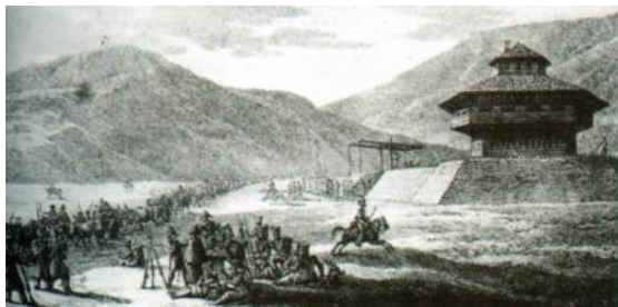
Abbildung 3: Französisches Blockhaus in den Pyrenäen während des Spanienfeldzuges 1808-1813, hier als Sicherung einer Heeresstraße an einem Übergang und als sicherer Stützpunkt kleiner Kommandos. Das Blockhaus ist noch durch einen vorgelegten Wall geschützt; der Zugang über den Graben erfolgt durch eine Klapprücke.
