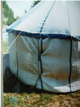
Abbildung 9: Geschlossener Eingang, der als einfacher Schlitz zwischen der Bahn gestaltet ist. Der Eingang läßt sich einfach durch das Aushängen der Seitenwand erweitern.
