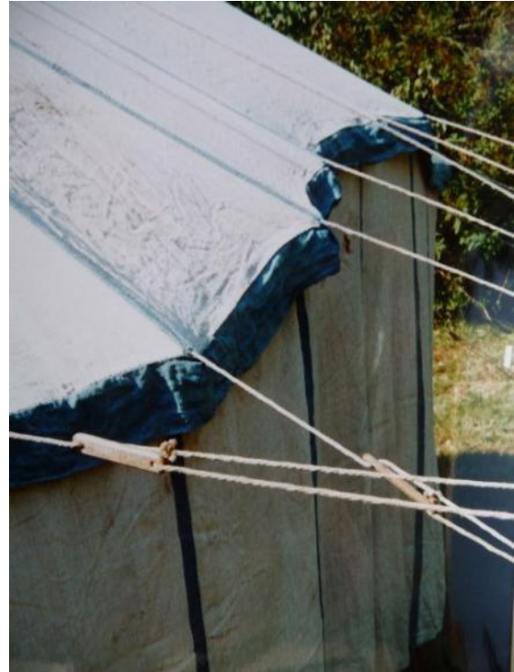
Abbildung 14: Seitliche Abspannung. Gut zu erkennen sind die Spannbrettchen und die Neigung der Seile, die etwas flacher als die Steigung des Daches verlaufen muß, um die Last der Seitenwände aufzufangen.
