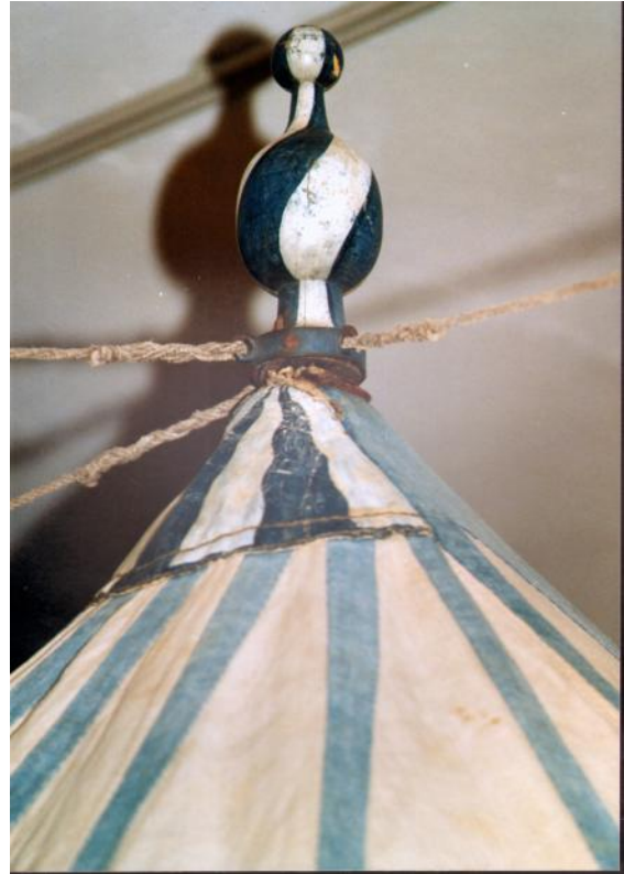
Abbildung 10: Knopf auf der Stange nimmt den Zug der Windleinen auf und dichtet den eisernen Dorn nach oben ab.
