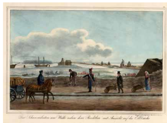
Abbildung 14: „Die Schanzarbeiten am Walle neben dem Brockthor mit Aussicht auf die Elbbrücke“. Im Mittelgrund die Blockhäuser an der Süderelbe. Unter dem Kommando eines Artilleristen fahren ein Bürger mit Rundhut (Zylinder) und eine Frau die Erde mit Schubkarren für die Brustwehr heran (Suhr).
