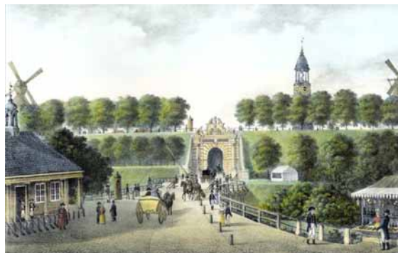
Abbildung 5: Das Millerntor am Hamburger Berg um 1790, also vor der Entfestigung. Im Vordergrund links das Wachthaus des Bürgermilitärs, dessen Nachfolgebau heute noch erhalten ist. Die Kurtine und der Niederwall sind bereits bepflanzt, Brücke, Zugbrücke und Toranlage sind dagegen noch intakt. Im Mittelgrund der Schlagbaum für Paßkontrolle und die Erhebung der Akzise (Christopher Suhr).
