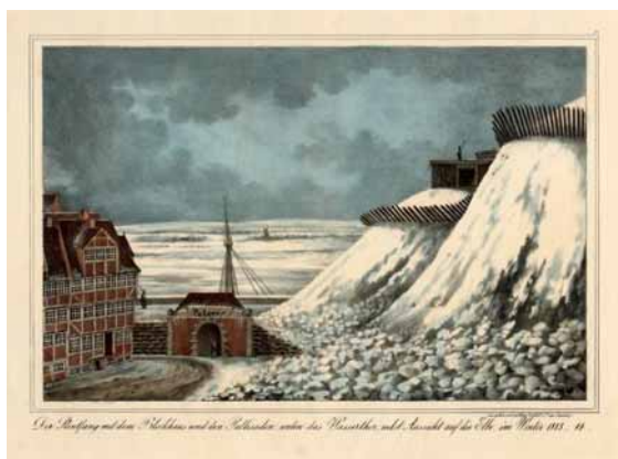
Abbildung 23: „Der Störfang [Störfang?] mit dem Blockhaus und den Pallisaden, unten das Wassertor [Poterne], nebst Aussicht auf die Elbe, im Winter 1813-14“. Die Kehlseite der Bastion Albertus als Reduit war mit Sturmpfählen (nicht Pallisaden) versehen, also fraisiert. Wie bei scharfem Frost oft üblich, wurde die Böschung mit Wasser übergossen, um das Ersteigen über die Eisfläche zu erschweren. Vergleiche mit Abbildung 24 (Suhr).
