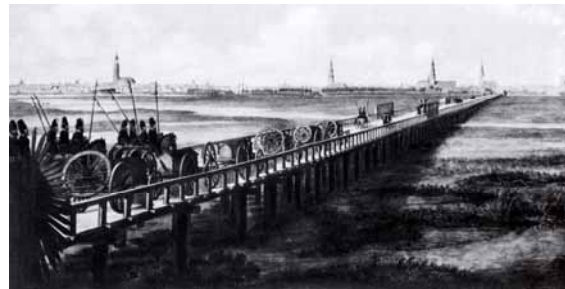
Abbildung 30: Übergang der Kosaken im Frühjahr 1814 auf dem südlichen Abschnitt der Brücke. Im Mittelgrund zwei hölzerne Wände mit eingeschnittenen Schießscharten für die Infanterie, im Hintergrund der Sommerdeich auf der Wilhelmsburg und dahinter Hamburg (Suhr).
