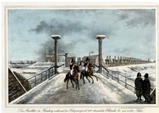
Abbildung 35: „Das Brockthor in Hamburg während der Belagerung 1813-14 und die Elbbrücke bis zur ersten Fähre“ Standort des Zeichners ist der Einschnitt des Brocktores, dessen Torgewölbe abgebrochen war. Der Graben im Fahrdamm wird mit einer Klappbrücke überquert. Hier sind dem Zeichner gleich mehrere Fehler in der Perspektive unterlaufen: Der auf den Plänen nicht nachweisbare, hier funktionlose Torbogen im linken Mittelgrund ist hier sowohl vor als auch hinter dem Wall. Er müßte aber hinter dem Wachthaus plaziert werden. Die rechts heranreitende Kolonne würde vor dem Wachthaus vorbeireiten, der Plan zeigt aber den Übergang hinter dem Wachthaus in der Mitte des Deckwalls, wie allgemein üblich. Der Damm ersetzt scheinbar den Wall, über den eine Klappbrücke führen müßte, der Plan zeigt aber eine Pfahlbrücke. Die Pfahlbrücke wäre laut Plan gar nicht von dem Standort des im Einschnitt sichtbar, da durch das Wachthaus verdeckt. Vergleiche Abbildung 36 (Suhr).
